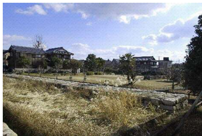
図 4-25 矢橋港の石積突堤
