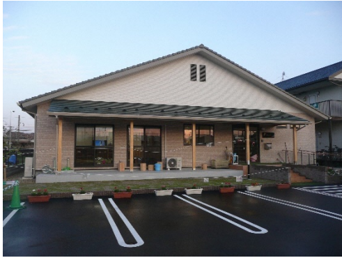
木造平屋建ての専用施設です。
