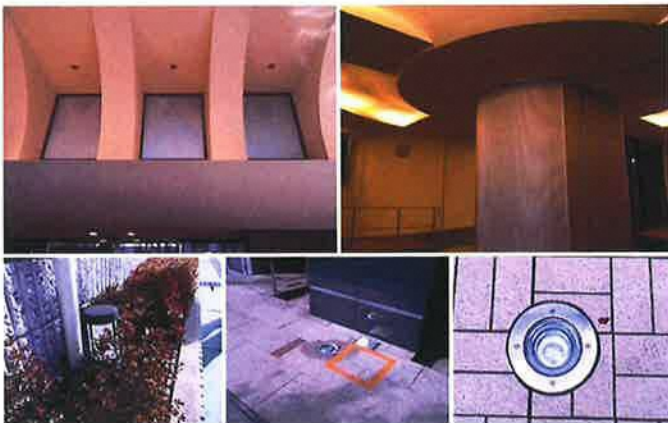
▲エントランスの常夜灯と外灯の間引き
