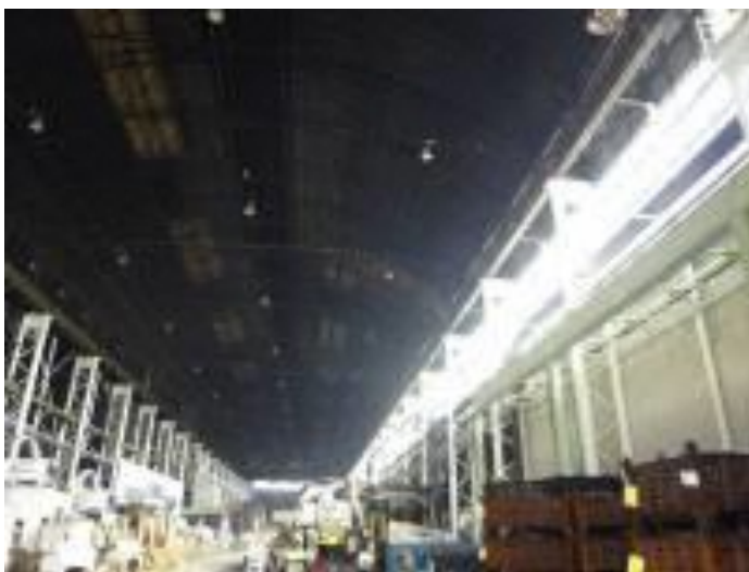
▲工場建屋採光窓の設置
