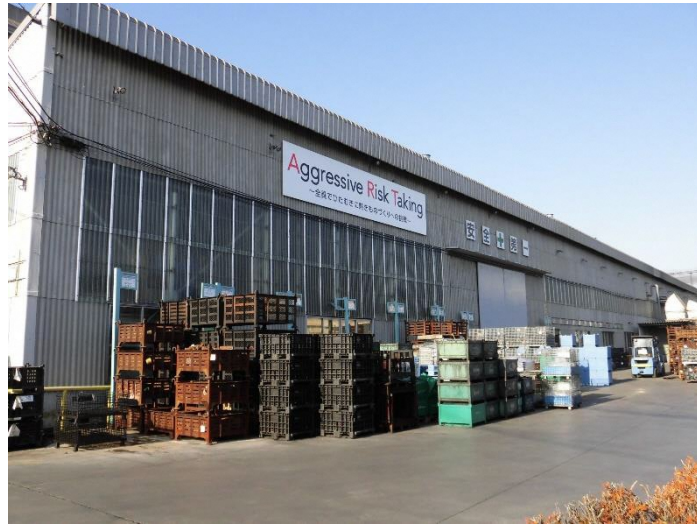
▲工場屋外/屋内照明のLED化
