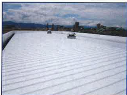
▲社屋屋根への「遮熱塗料」塗布
