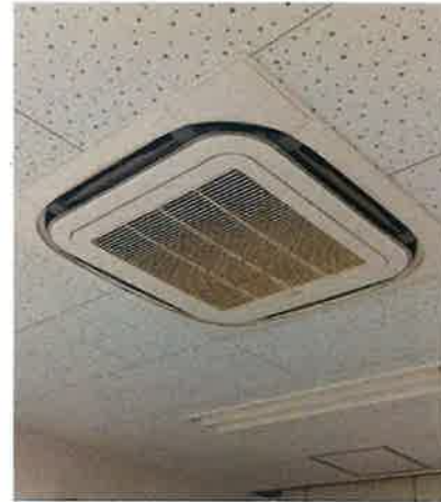
▲空調設備の更新
