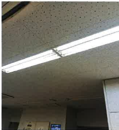
▲ LED照明への交換
