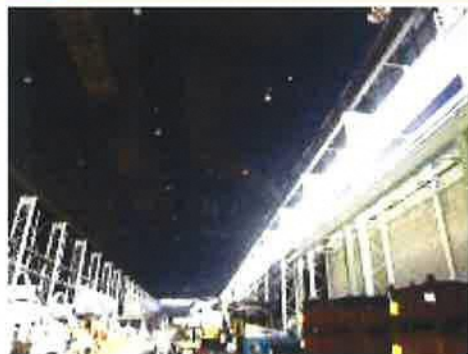
▲工場建屋採光窓の設置
