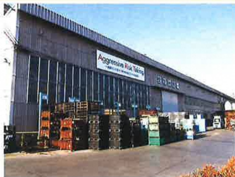
▲工場屋外/屋内照明のLED化
