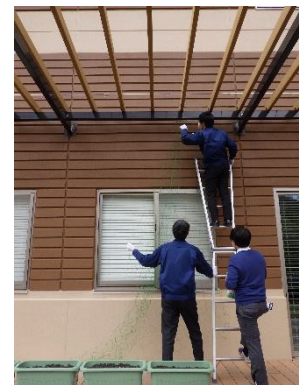
<ネット設置作業>
