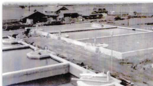
北山田浄水場完成
