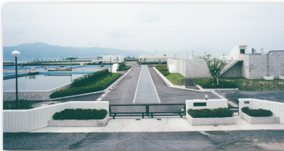
北山田浄水場拡張工事
