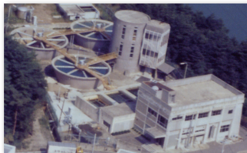
口クハ浄水場新設
