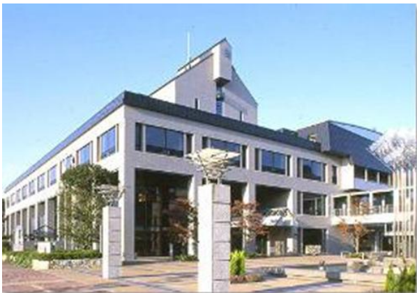
市庁舎：平成 4 年 5 月竣工
