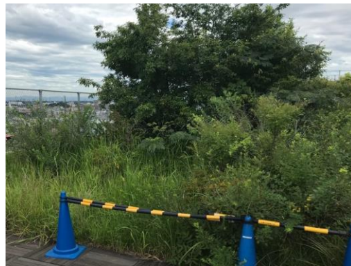
管理が難しい屋上ビオトープ
