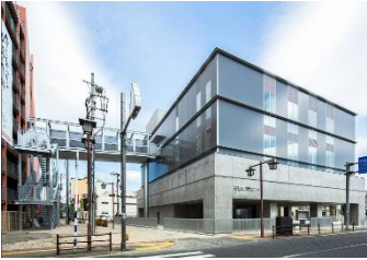
▼イメージ（石巻市防災センター）
