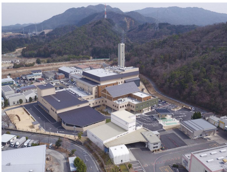
草津市立クリーンセンター
