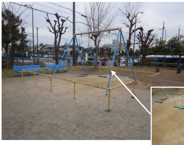
公園の老朽化した遊具 支柱に劣化がみられる。
