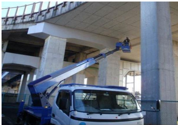
橋梁の定期点検 橋梁の打音・目視検査の様子
