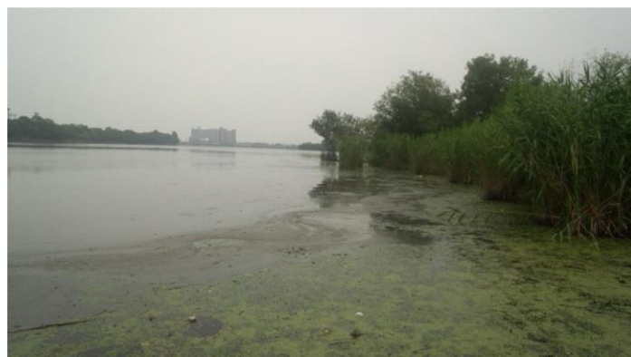
中間水路の状況（新浜第2樋門付近）
