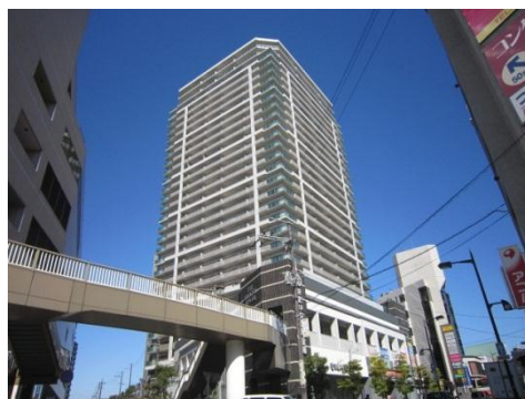
●図 10-10 草津タワーの写真
