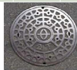
旧規格マンホール蓋 (穴あきタイプ)
