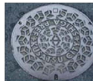
新規格マンホール蓋 (雨水浸入防止型)
