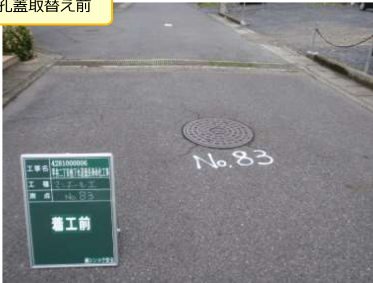
マンホール蓋の劣化イメージ
