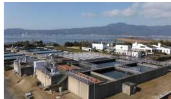
北山田浄水場
