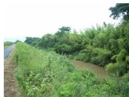
⑨河川状況、樹木群
