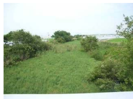
①湖岸道路から上流側の河川状況
