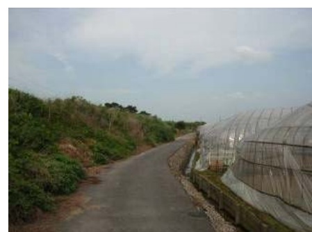
⑦沿川からの堤防状況
