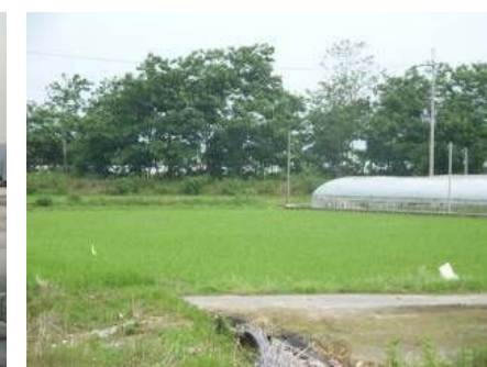
⑫沿川からの堤防状況
