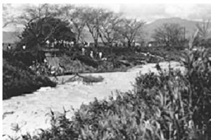
図 1-8 台風13号により決壊した堤防*
