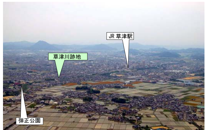
図 1-3 航空写真(弾正公園～上流部)
