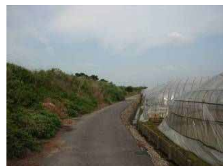
沿川からの堤防状況
