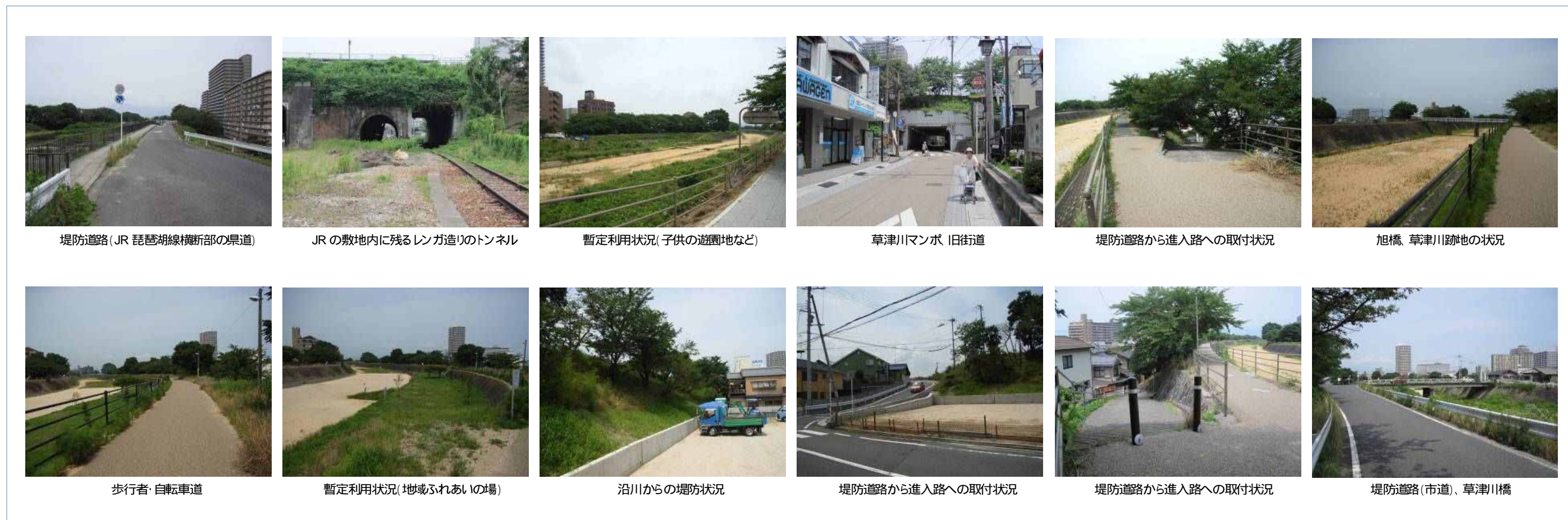
図 3-14 現状写真 (区間 )
