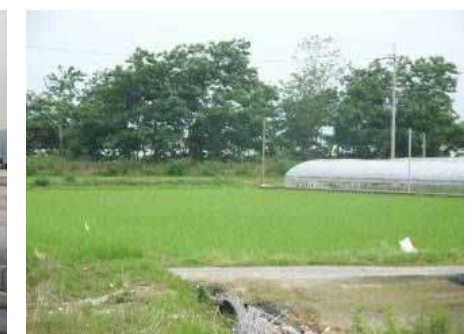
沿川からの堤防状況
