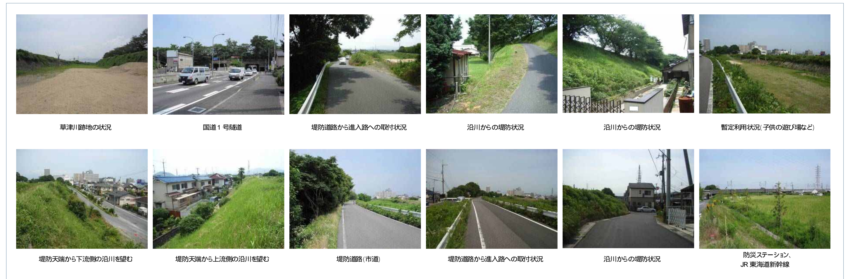
図 3-16 現状写真(区間 )
