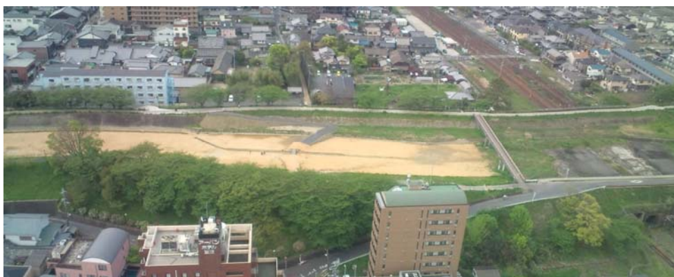
図 5-8 区間⑤(草津川マンポ付近)の草津川跡地
