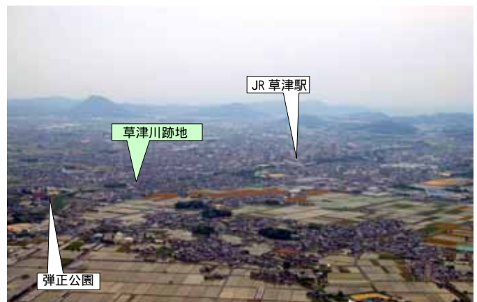
図 1-3 航空写真(弾正公園～上流部)
