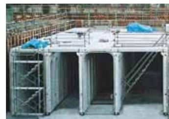
図 4-8 地下貯水槽(防火用水施設)のイメージ
