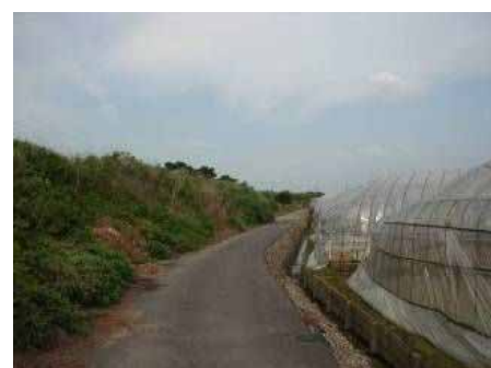
沿川からの堤防状況
