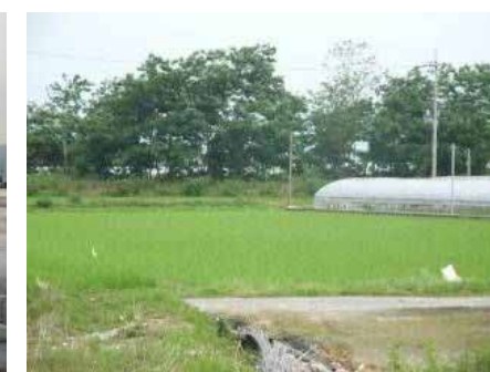
沿川からの堤防状況
