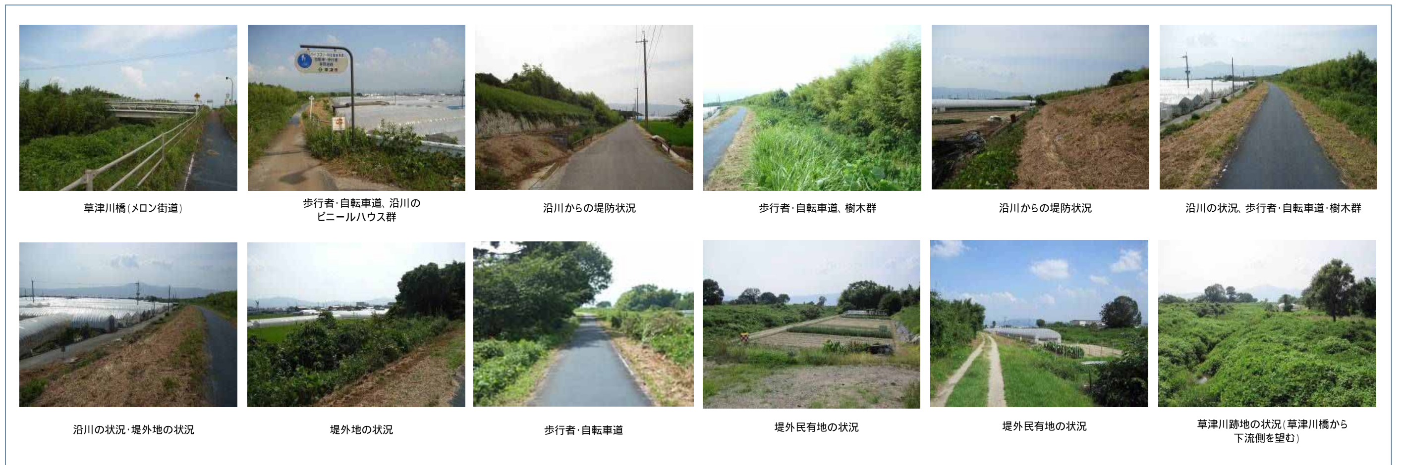
図 3-8 現状写真(区間 )
