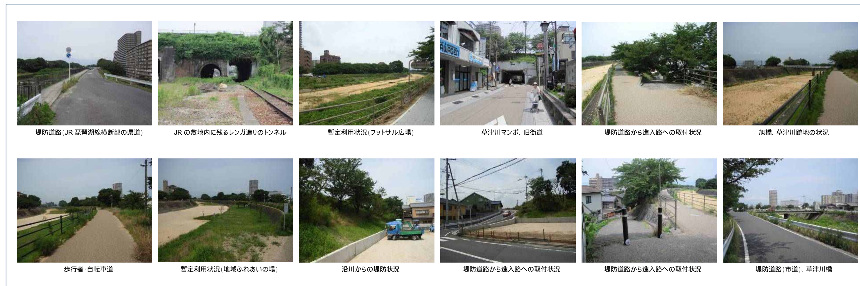
図 3-14 現状写真(区間 )
