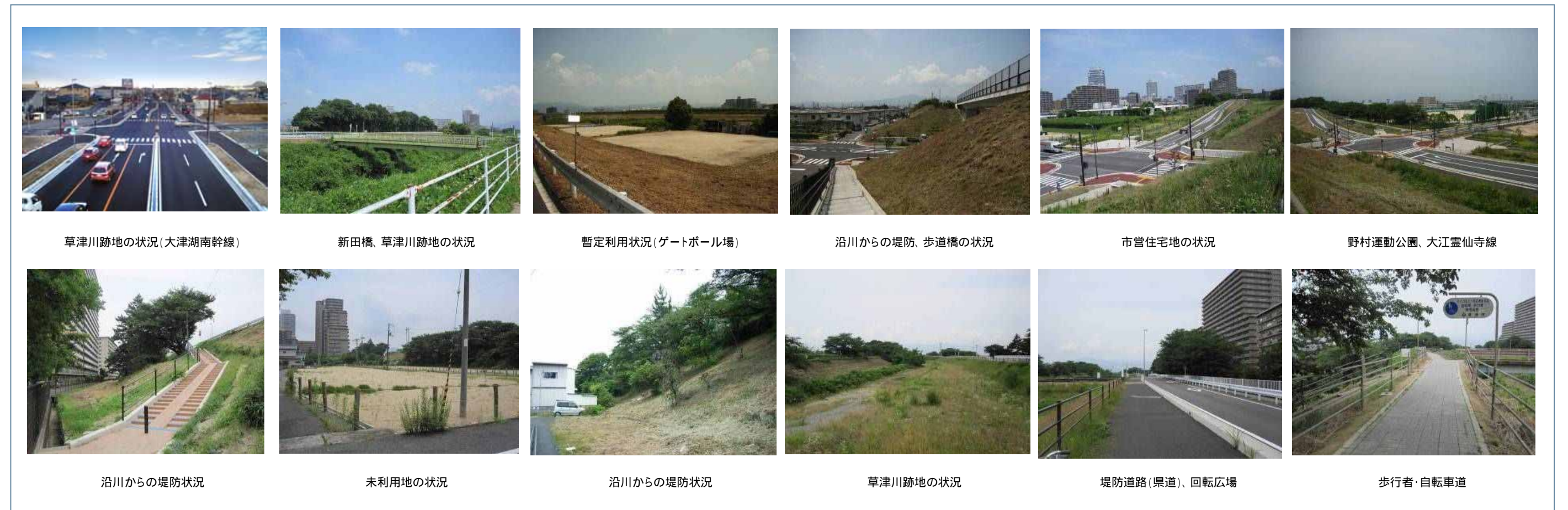
図 3-12 現状写真(区間 )
