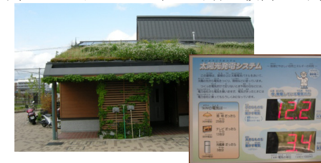
管理棟屋根のソーラー発電と緑化屋根
