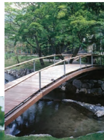
自然に調和した橋→
