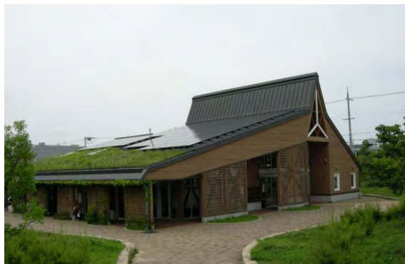
ソーラーパネルによる屋根上の発電、屋根を緑化により室内への熱伝導を抑える工夫
