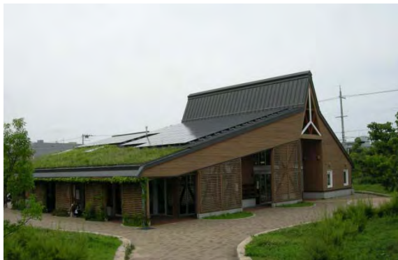
ソーラーパネルによる屋根上の発電、屋根を緑化により室内への熱伝導を抑える工夫
