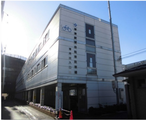
○草津駅東自転車駐車場
