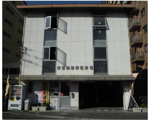
○草津駅西口自転車駐車場
