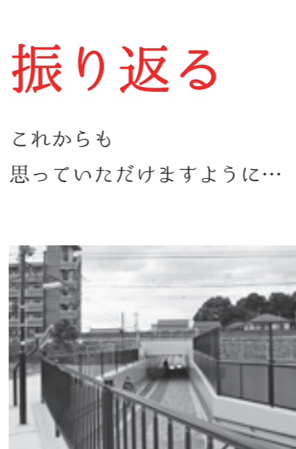
3月 矢倉隧道の供用開始(写真③)
