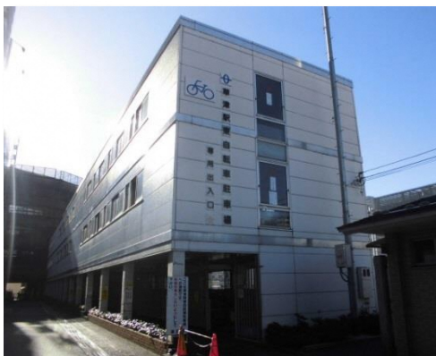
○草津駅東自転車駐車場
