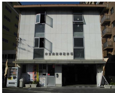
○草津駅西口自転車駐車場
