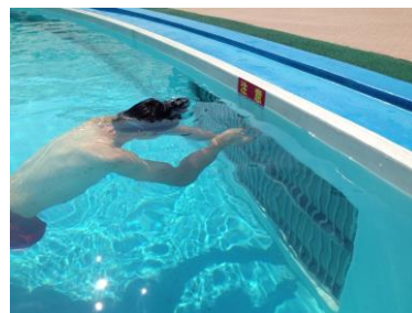
【ろ過吐出柵のチェック】
