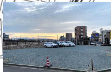
福井市所有の空地进行河川敷利用時の拠点施設設置場所として整備
