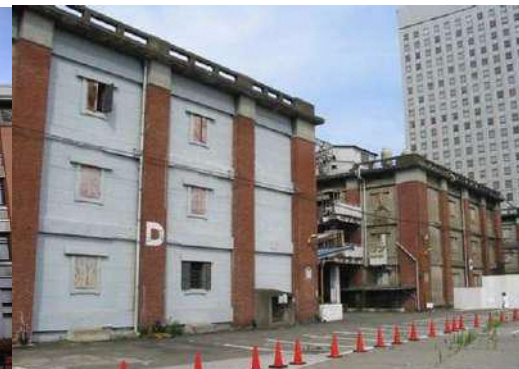
旧帝蚕倉庫（3棟解体、1棟復元）
