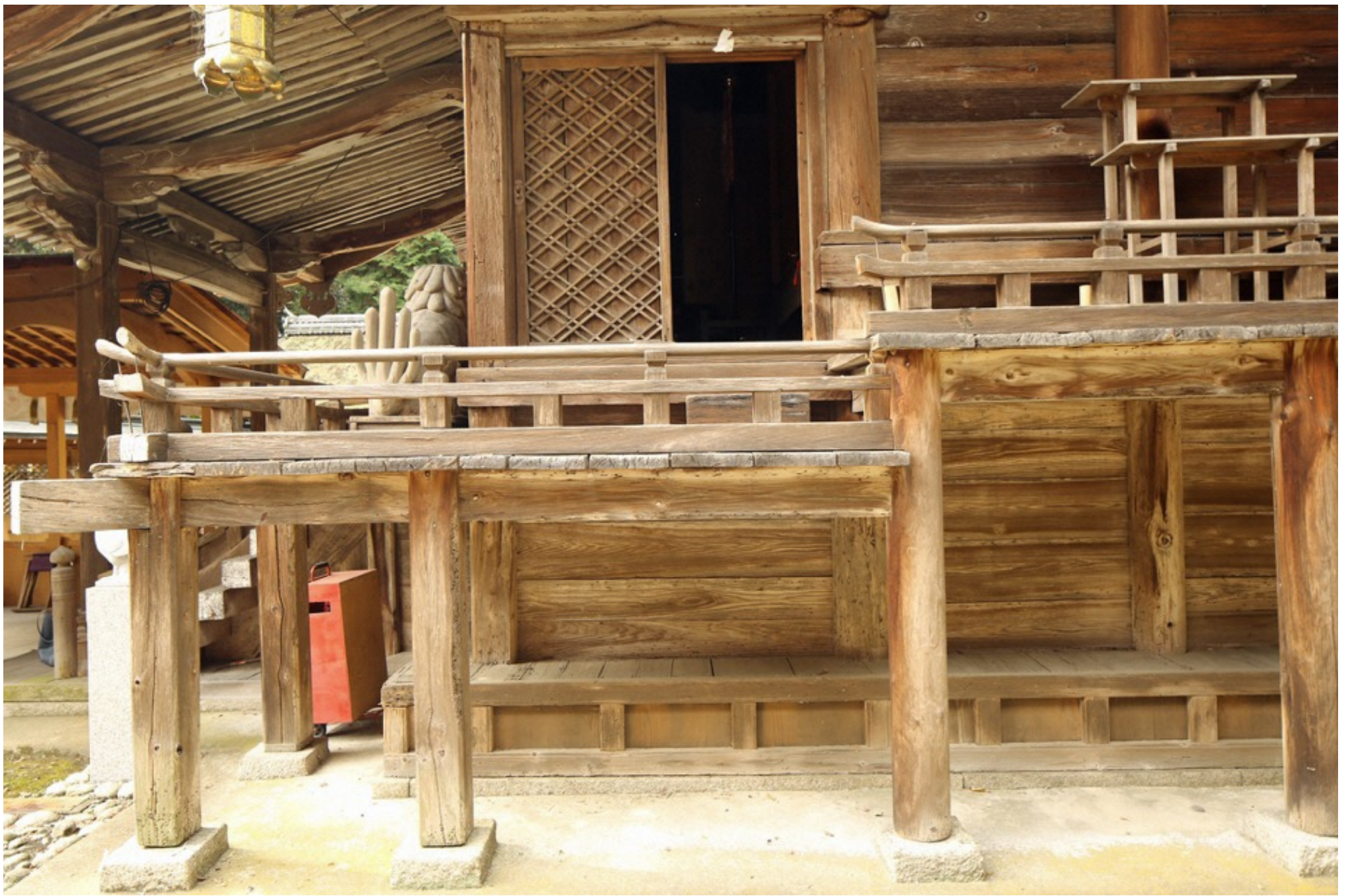
印岐志呂神社本殿の縁下の腰掛け
