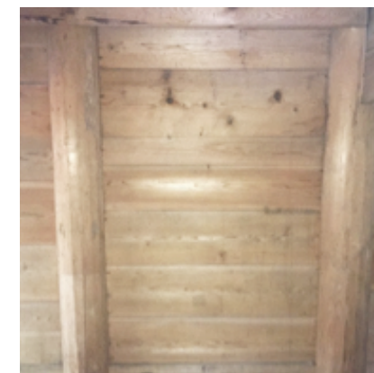
印岐志呂神社本殿の床下の柱
