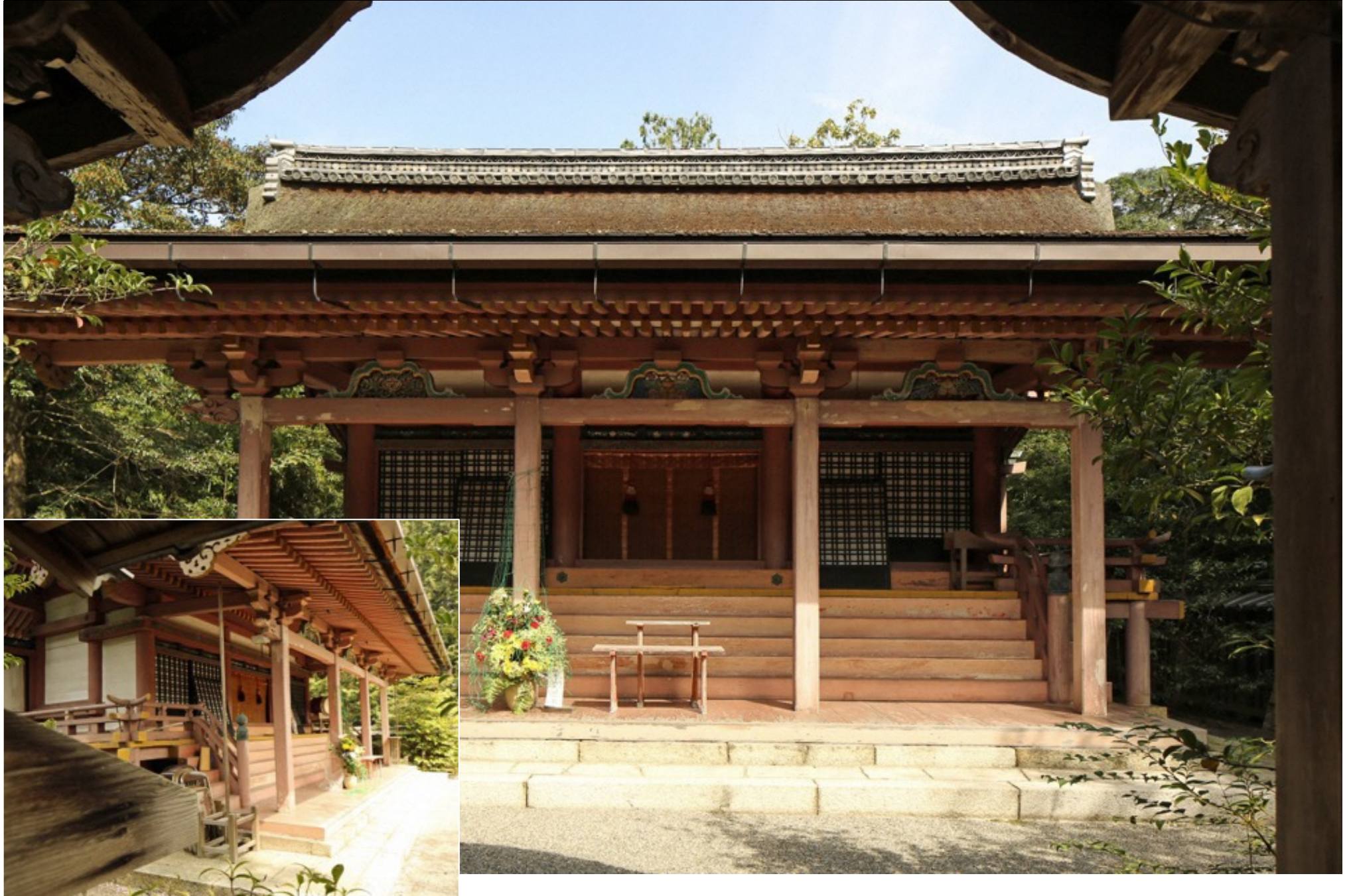
老杉神社本殿 室町時代、宝徳4（1453）年：棟木墨書【重文】 前室付三間社流造（母屋前間を前室とする）／向拝三間幅
