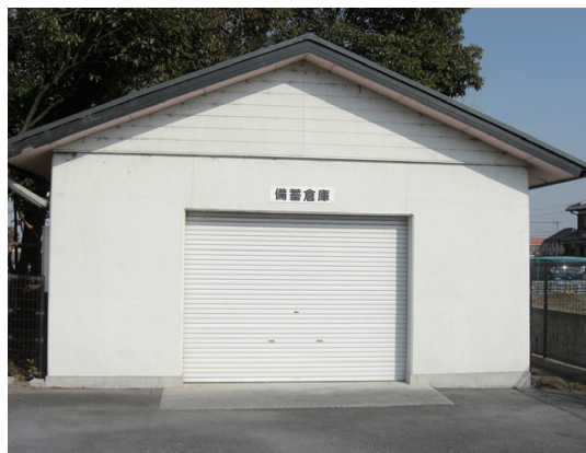
防災びちく倉庫
