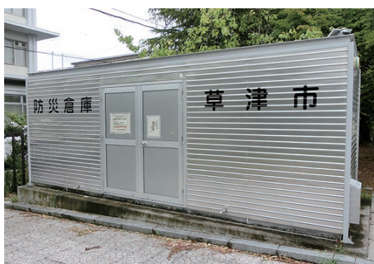
↑ 防災びちく倉庫
