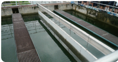
薬品沈でん池
