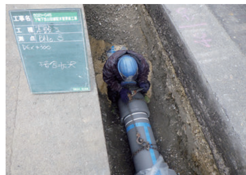
配水管の取りかえの様子
