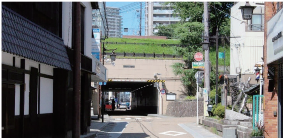
↑現在の草津マンポの様子 草津1丁目と大路1丁目の間にあるトンネルで「草津マンポ」とよばれています。
