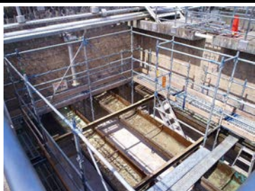
ロクハ浄水場新館急速ろ過池耐震補強工事の状況
