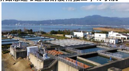
北山田浄水場
