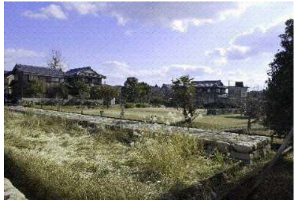
[写真 50] 矢橋港の石積突堤
