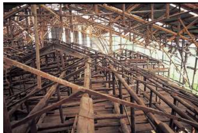
過去の整備の様子 (座敷部の小屋組みの様子)
