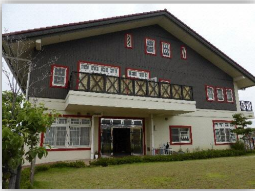
アルプスの山小屋風の園舎
