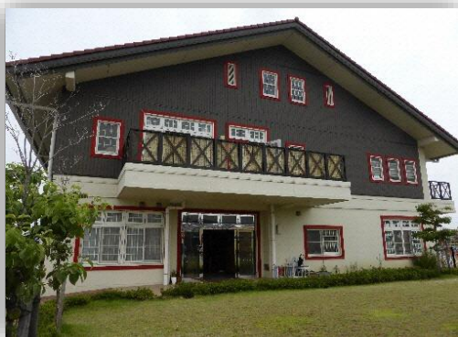
アルプスの山小屋風の園舎
