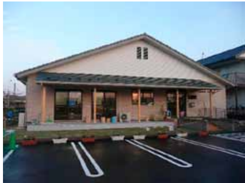
木造平屋建ての専用施設です。
