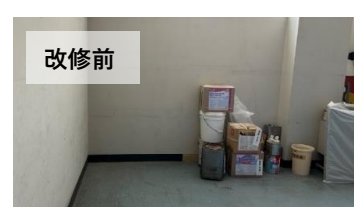
多目的トイレ
