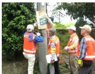
除却作業風景 1
