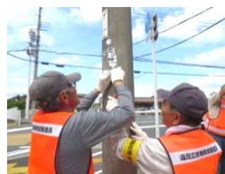
除却作業風景 2
